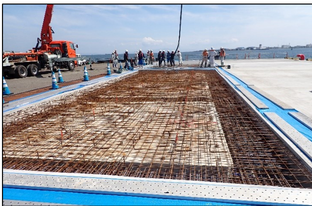
RC(鉄筋コンクリート)の現場での打設
