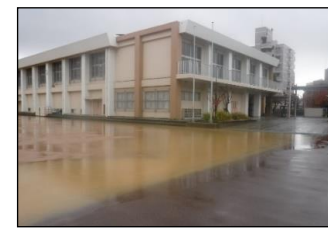
雨水流出抑制施設(枝庭貯留)
