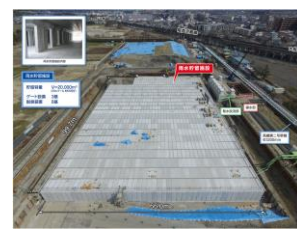
雨水貯留施設(安満遺跡公園)
