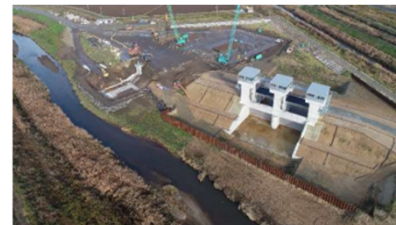
渋井川水門（出典：宮城県北部土木事務所HP）
