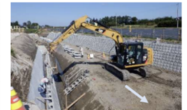
名蓋川災害復旧工（出典：宮城県北部土木事務所HP）
