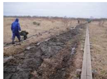
水抜き水路の埋め戻し
