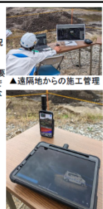
▲3D計測端末とAR端末（3Dの方は座標以外に色データも取得している）
