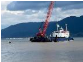
浚渫作業の状況 (R6.10)
