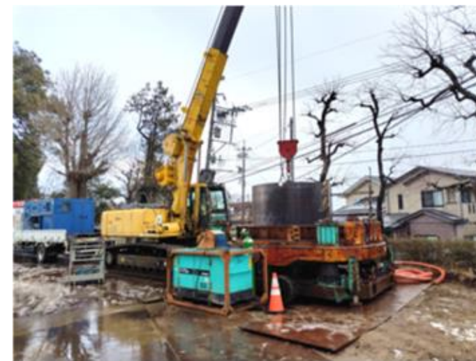
実証実験施工状況 (金沢市)
