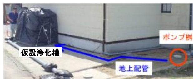
○珠洲市における応急復旧状況 早期の排水再開を要望する住宅等に仮設浄化槽を設置して応急復旧
