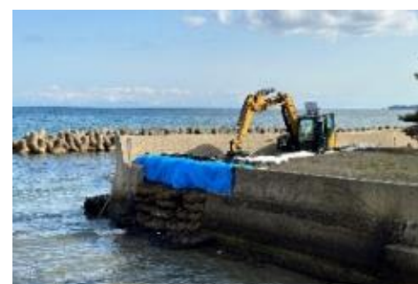
袋詰玉石、大型土のう敷設完了
