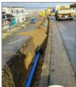
○珠洲市における応急復旧 大谷浄水場から清水地区への仮設配管
