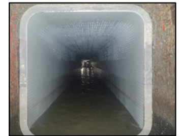
耐震対策後(管更生)
