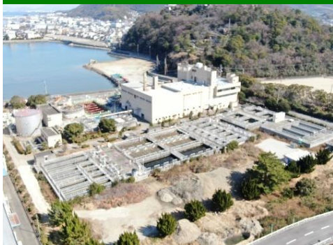
下水道事業(川の江浄化センター)
