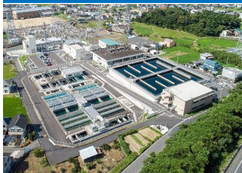
水道事業(中田井浄水場)
