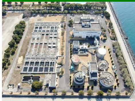
下水道事業(三島浄化センター)
