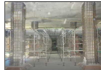
土木躯体の耐震補強
