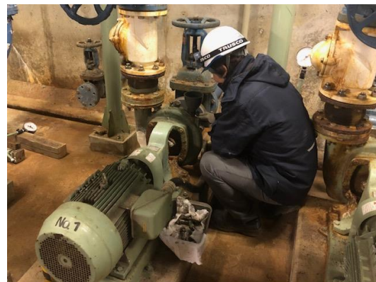
維持管理業者による修繕
