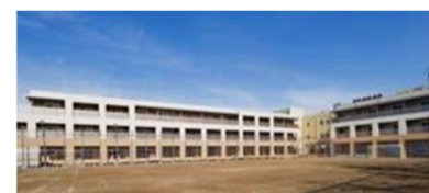
学校を改修して整備した住宅
