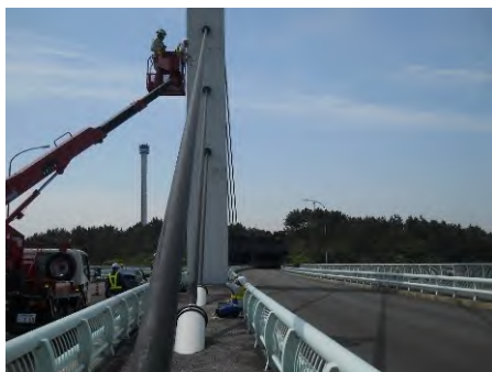
高所作業車による近接目視
