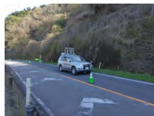
MMS※1を活用した 斜面・のり面点検
