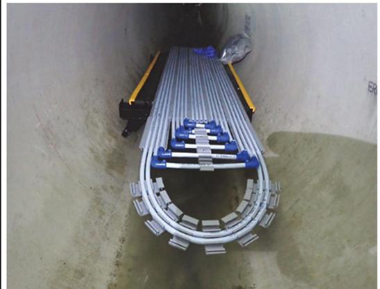
下水道管内に設置した熱交換器
