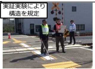
踏切道内誘導表示の設置
