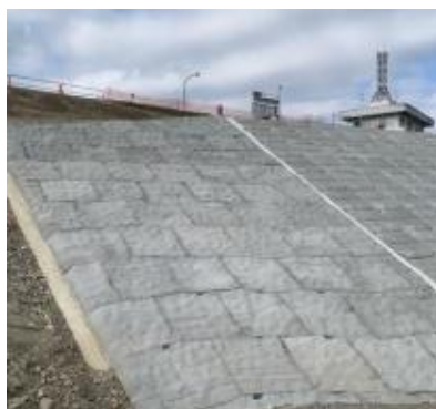
写真-5 護岸ブロック
