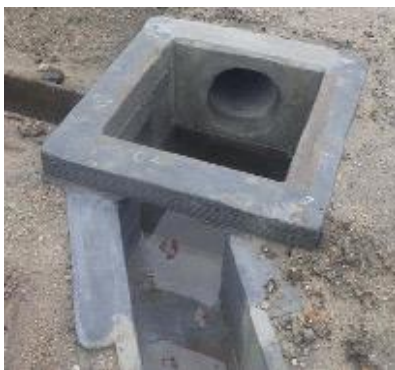
写真-1 集水枠と側溝の一体型
