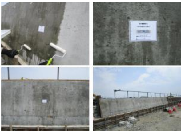
図－4 堤防新設工事における使用写真
