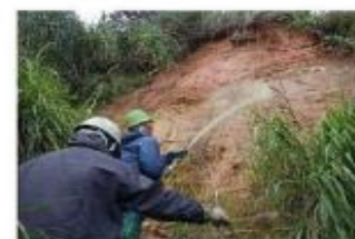
吹付状況例（崩壊斜面）
