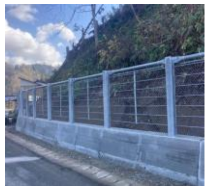
写真-6 重力式擁壁
