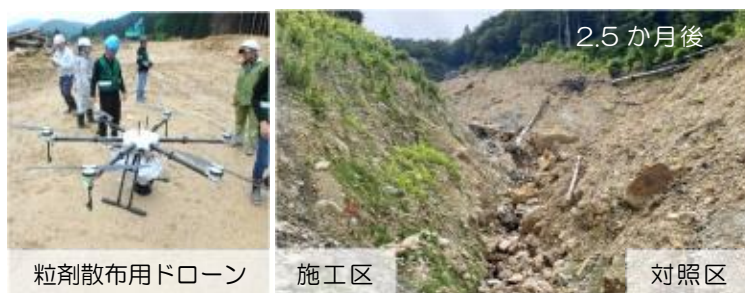
図一 4 ドローン散布工検証時の様子
