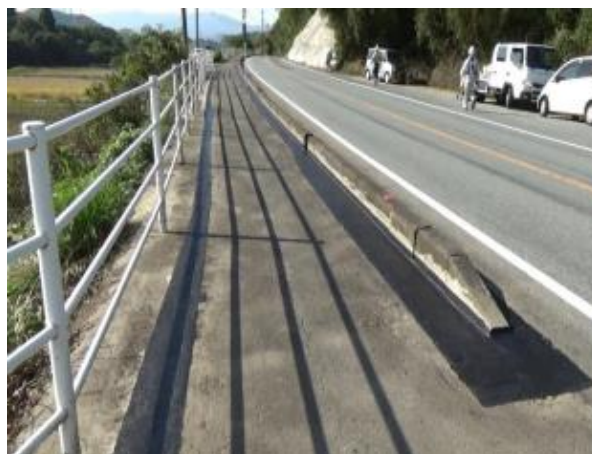
熊本県宇城市 国道218号【施工完了】
