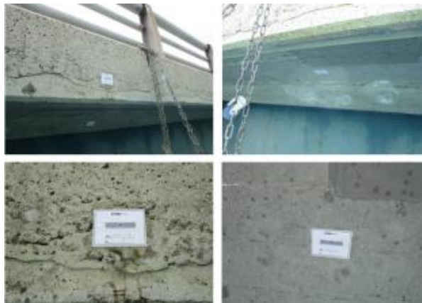
図－3 橋梁補修工事における使用写真
