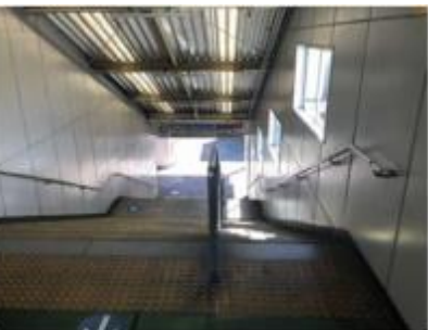
既存の駅の通路
