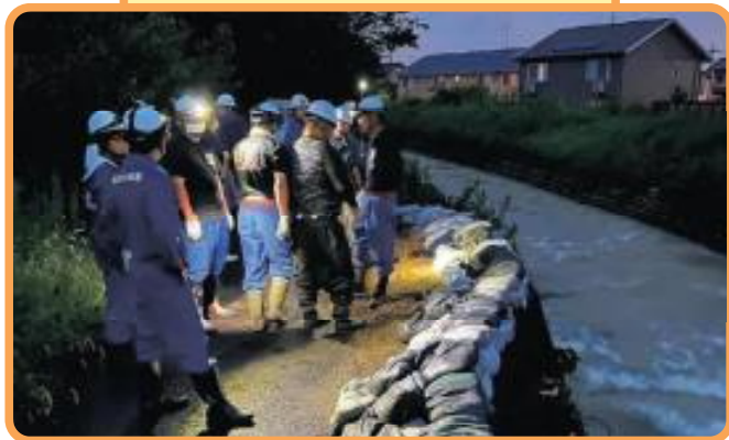
水防工法(土のう積み)
