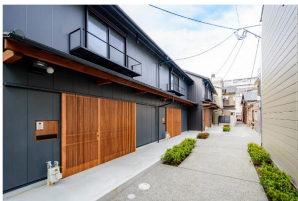
【下京区中堂寺前田町路地再生長屋プロジェクト】 防災性向上とコミュニティ形成を実現した路地再生モデル住宅
