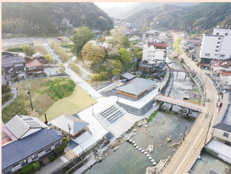
エリア全体の様子
