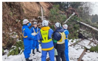
【TEC-FORCE・RAIL-FORCE による現地調査 (のと鉄道 和倉温泉駅～穴水駅間)】
