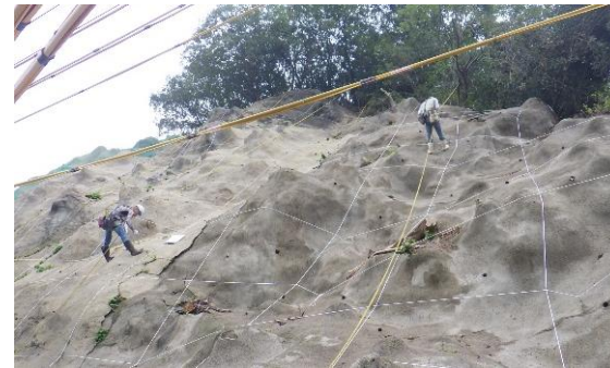
ロープアクセスによるのり面点検
