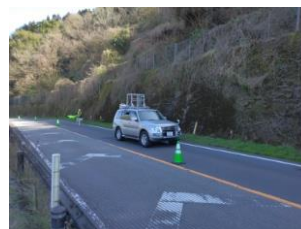
MMS※1を活用した 斜面・のり面点検
