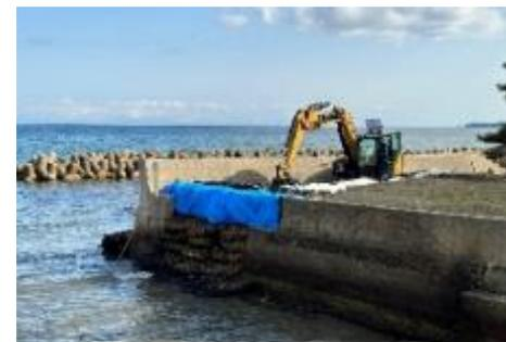
袋詰玉石、大型土のう敷設完了
