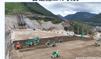
自動施工の状況
