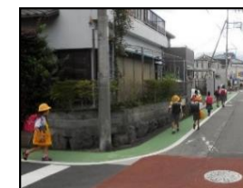
路肩のカラー舗装
