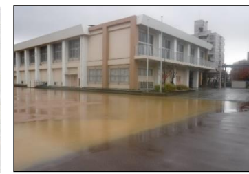
雨水流出抑制施設(校庭貯留)
