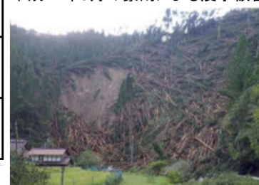
平成30年台風第21号による倒木被害
