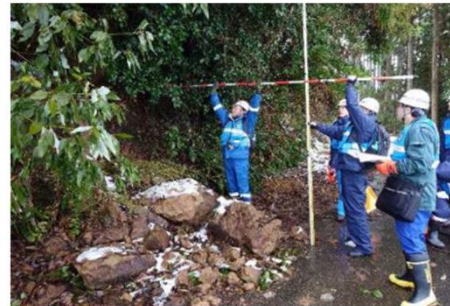
速やかな被災状況調査
