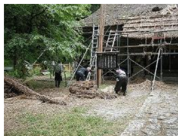
定期的な修復作業
