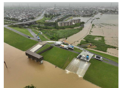
ふるかわ 雄物川水系古川付近の浸水状況 （秋田県秋田市）
