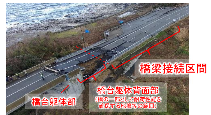
橋台躯体構造区間
