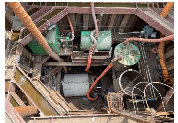
推進工法による下水遮集管渠 の施工状況 ※鉄建建設(株)提供
