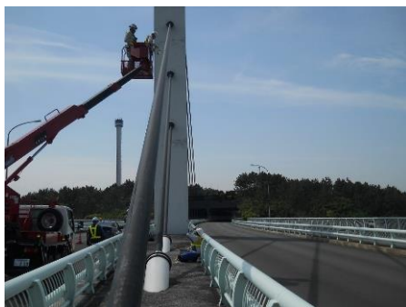
高所作業車による近接目視
