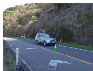
MMS※1を活用した 斜面・のり面点検
