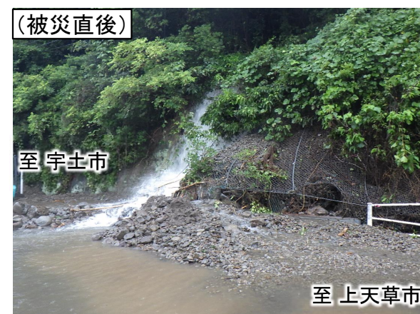
④国道57号(熊本県宇城市三角町) 土砂流入箇所における本格復旧工事を実施
