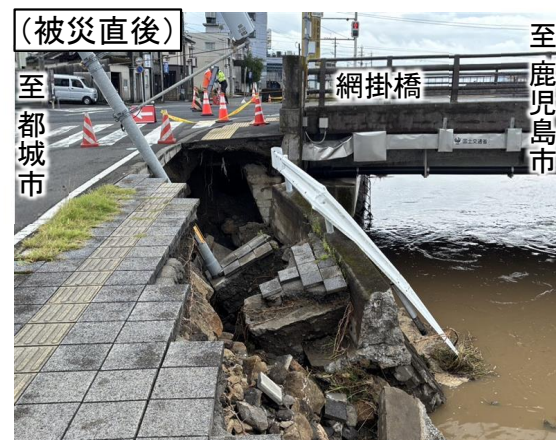
③国道10号(鹿児島県始良市加治木町本町) 橋台背面等の洗掘箇所の応急復旧工事を実施
