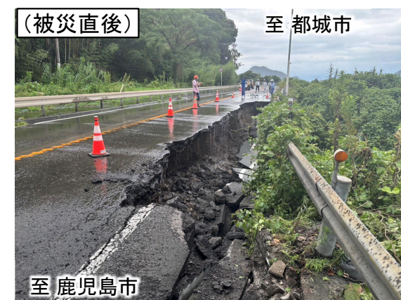
②国道10号(鹿児島県霧島市隼人町野久美田) 路肩崩落箇所における本格復旧工事を実施
