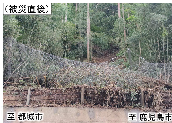
①国道10号(鹿児島県始良市加治木町日木山) 土砂流入箇所における本格復旧工事を実施
