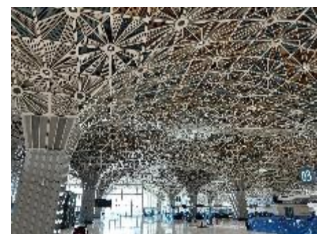
■ 新国際線ターミナル整備の状況 (2024年7月17日)
