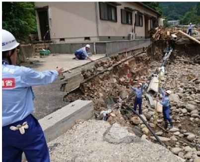
河川被害状況の調査
