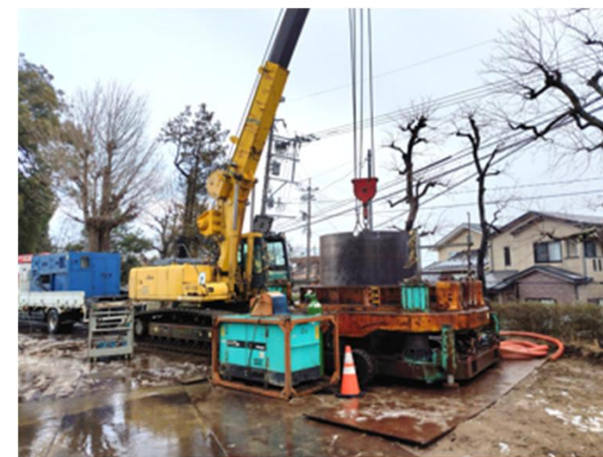
実証実験施工状況(金沢市)
