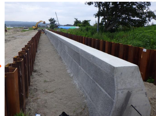
本復旧状況（護岸復旧）
