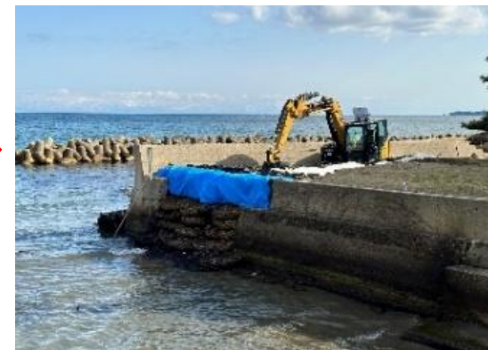
袋詰玉石、大型土のう敷設完了
