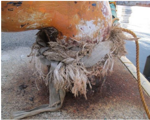
写真7：劣悪な係留ロープ
