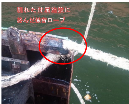
写真9：付属施設に絡んだ係留ロープ
