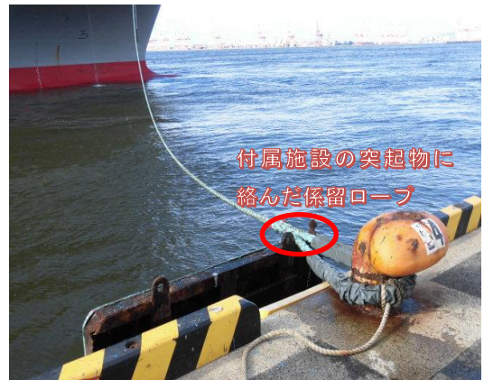
写真8：付属施設に絡んだ係留ロープ
