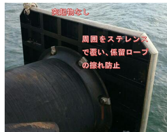
写真10：係留ロープが絡みにくい対策
