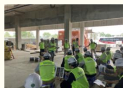
施工現場視察
