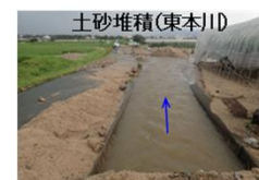
土砂堆積(東本川)
