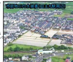
▲R5.7洪水における浸水被害状況
