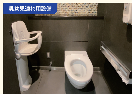
提供：大阪市高速電気軌道（株）
