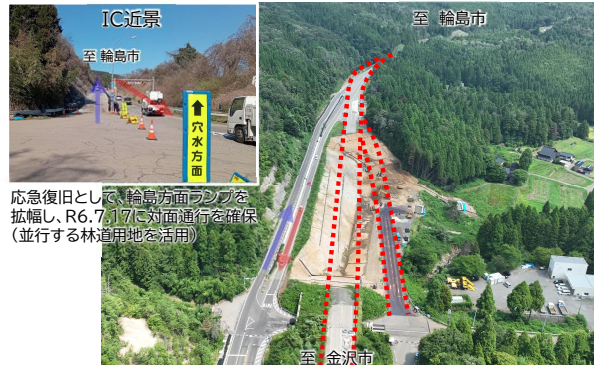
復旧状況 (本線・金沢方面オフランプの崩土撤去状況)
