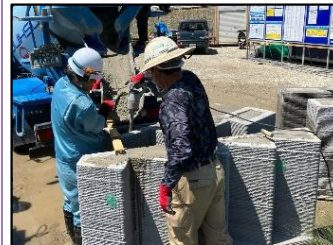
中詰コンクリート打設
