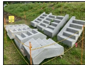
階段部材造形完了
