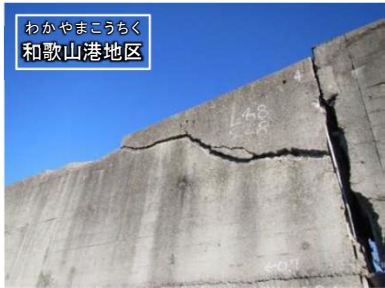
護岸(波返工上部の剥離)
