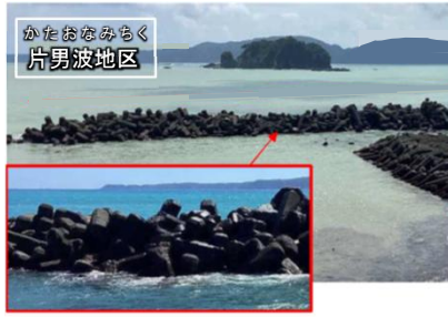
離岸堤(消波ブロックの破損・飛散)
