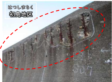
護岸(波返工の剥離・欠損)
