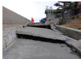
護岸・水叩き損傷
