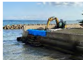
袋詰玉石、大型土のう敷設完了
