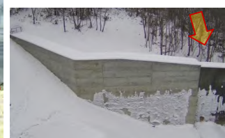
令和6年度施工状況(右岸袖部改築)
