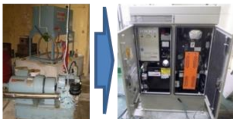
老朽化発電機の換装
