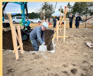
端部はスコップを用いて人力作業
