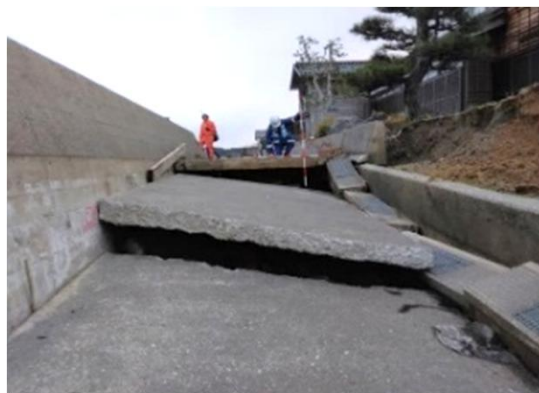
護岸・水叩き損傷
