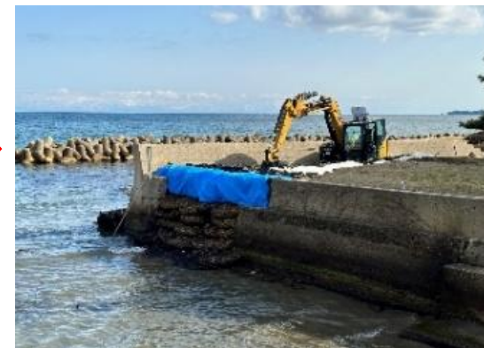
袋詰玉石、大型土のう敷設完了
