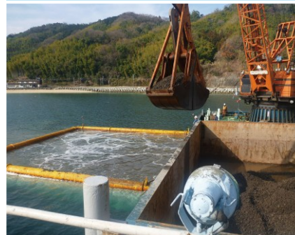
鉄鋼スラグ製品の設置作業
