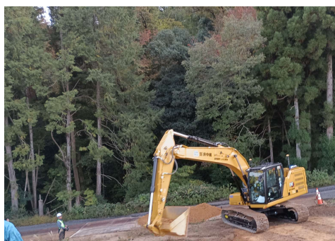
（ICT建機の遠隔操作による崩落土砂撤去）
