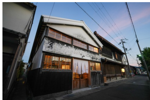
古民家オーベルジュ施設として改修した「旧戸田家住宅」
