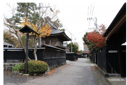
無電柱化対象路線である市道安善寺線 あんぜんじせん
