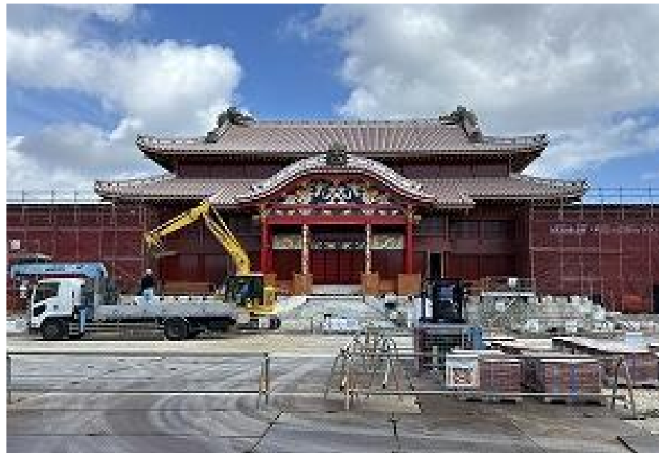
▲首里城正殿工事の様子(R8. 2月時点)
