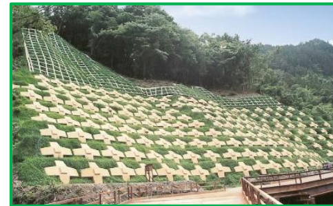
アンカー工 施工イメージ
