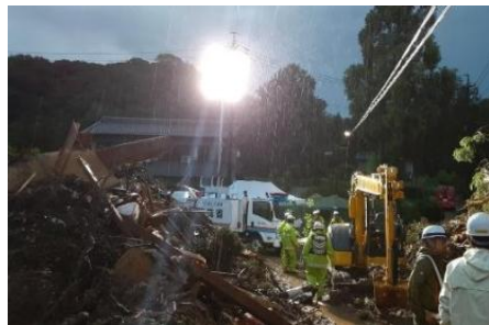
照明車による救命救助の支援 (令和6年台風第10号)
