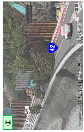
① 法面崩落の状況(R4.6) [串本町上浦地先] ② 越波の状況(R5.8) [串本町地先]
