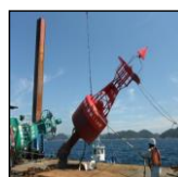
<灯浮標の設置>
